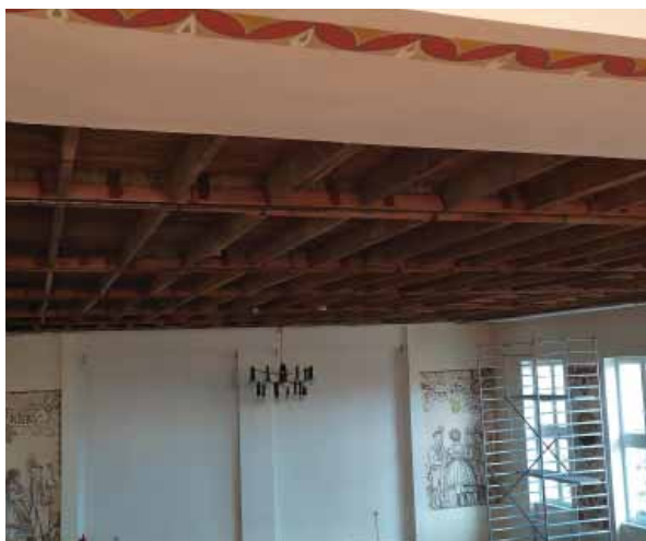
Oprava stropu v KD
