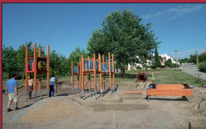
Stavba dětského hřiště
